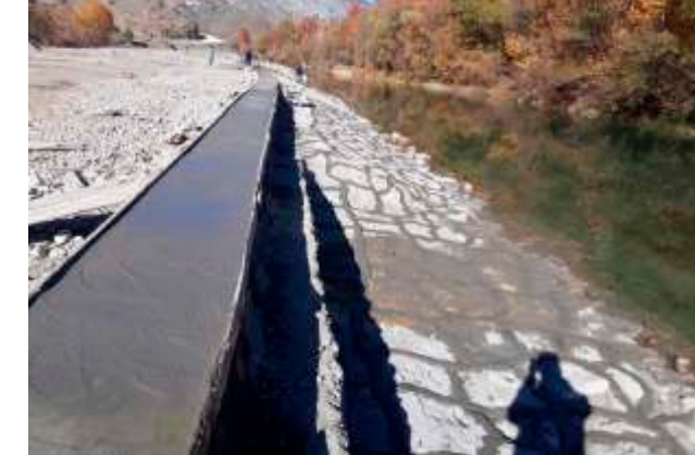
GASKİ Düzbağ Herete İstinat Duvarı Yapım İşi
