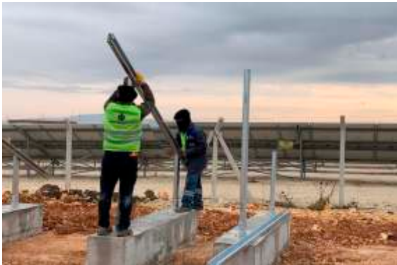
İNCESU2 1 MW Güneş Enerji Santrali Kurulumu
